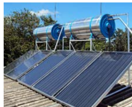
Serão 560 m 2 de placas coletoras e reservatórios instalados
